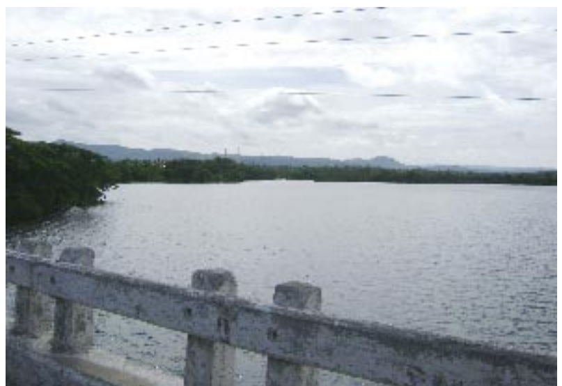
Presa "Carlos Manuel de Céspedes", en la provincia de Santiago de Cuba.
