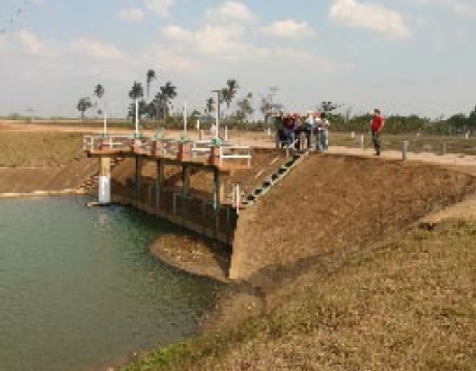
Inspeccionando una obra.
