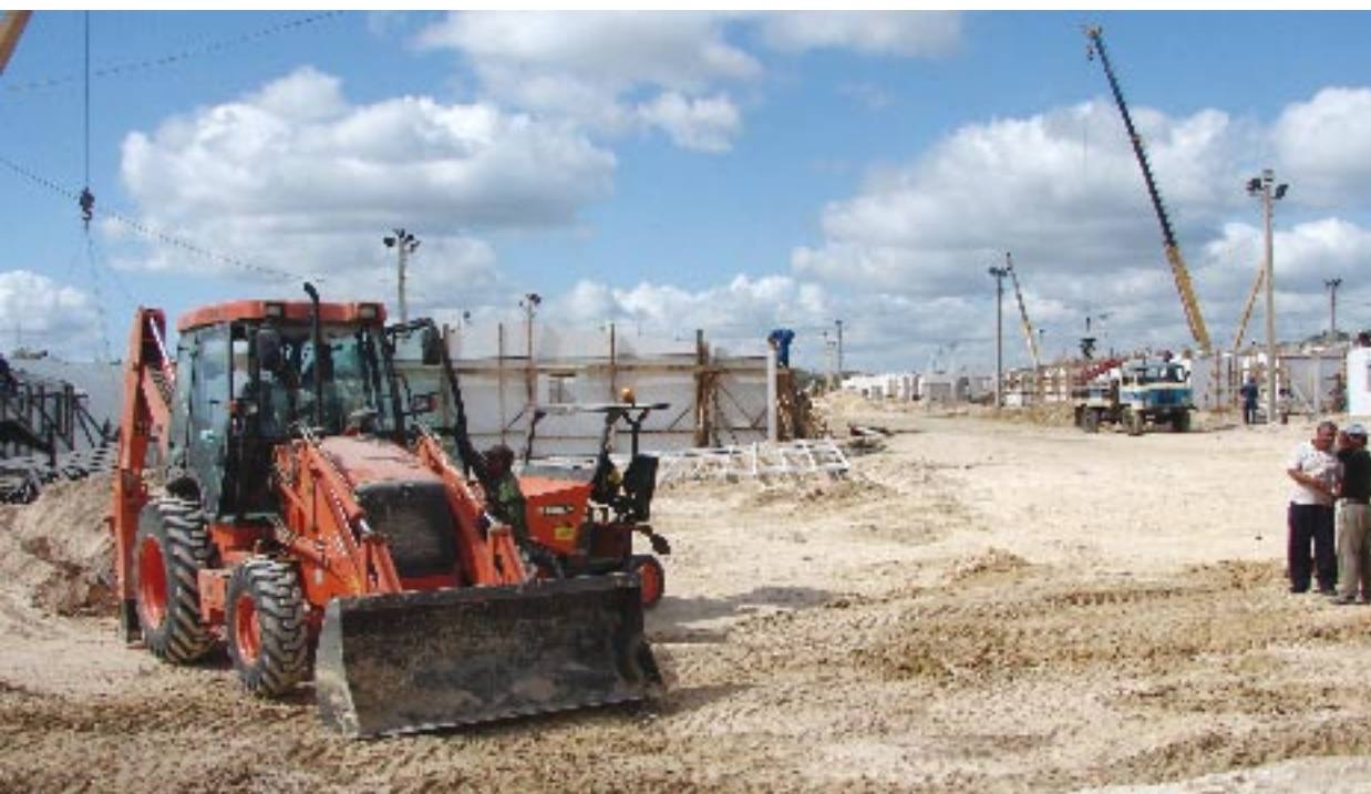
Ejecución de la red urbana integral en el Barrio de las 100 Petrocasas.
