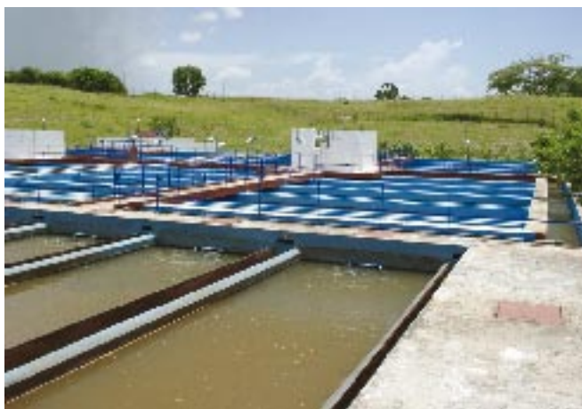
En el 2008 se terminaron cuatro potabilizadoras: Palmarito, Cruces, El Recreo y Los Naranjos.
