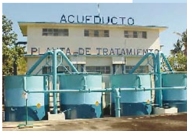
Se concluyó el pasado año la construcción de 16 acueductos.
