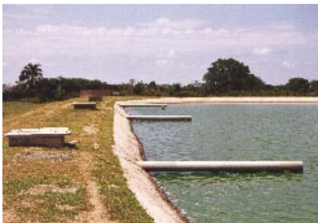
En el 2008 fueron terminados cuatro sistemas de tratamiento de residuales.
