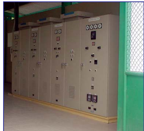
Fig. 4. Paneles de control automático.
