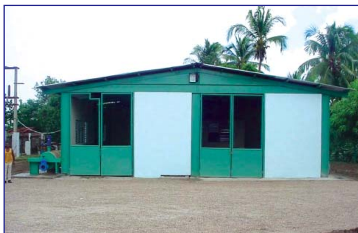
Fig. 2. Nueva estación de bombeo Bano.
