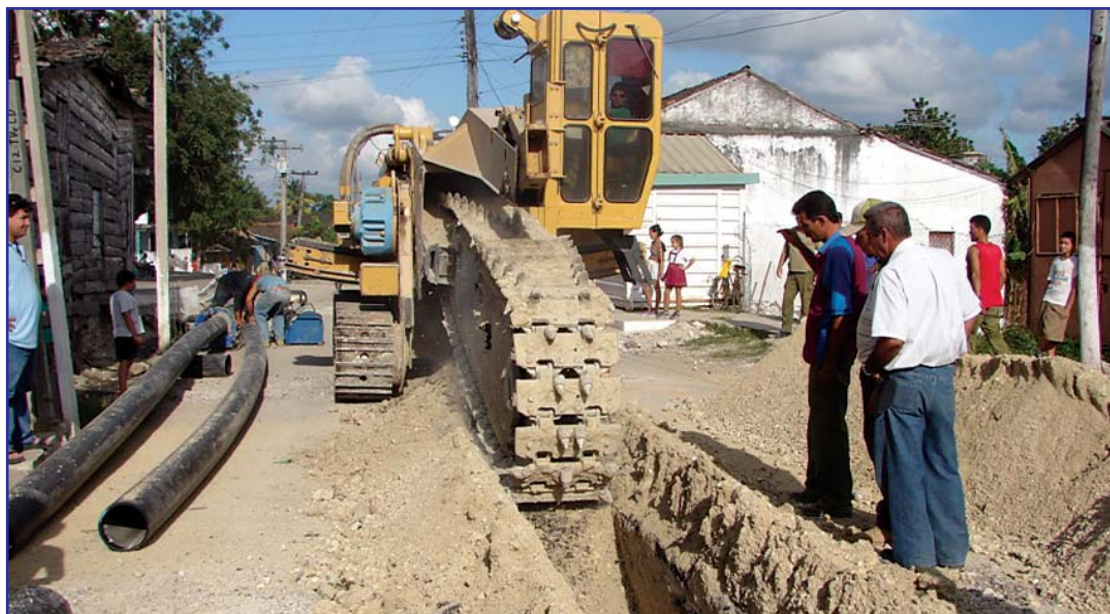
Excavadora Vermeer ejecutando la zanja en roca.
